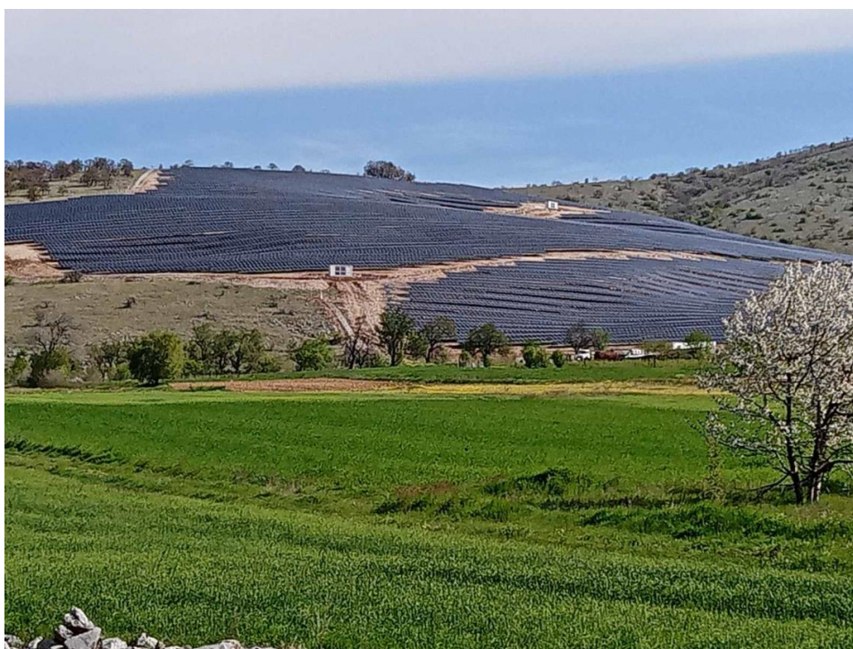
Εικόνα 9. Φωτοβολταϊκά στα Αλωνάκια.
