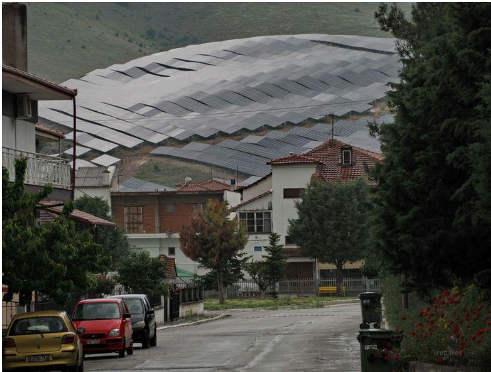
Εικόνα 4. Φωτοβολταϊκά στα Κοίλα Κοζάνης.
